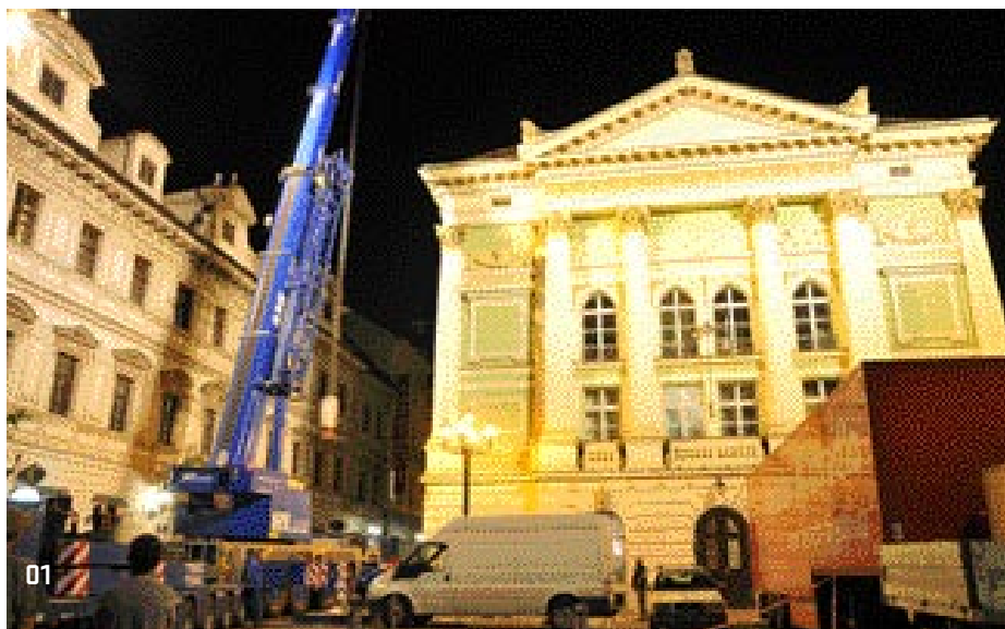
01 > Zavážení kotlů pod střechu provozní budovy divadla Kolowrat
