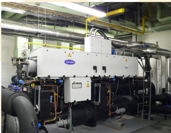
Reverzní chladicí stroj Carrier využívá teplo z vltavské vody
